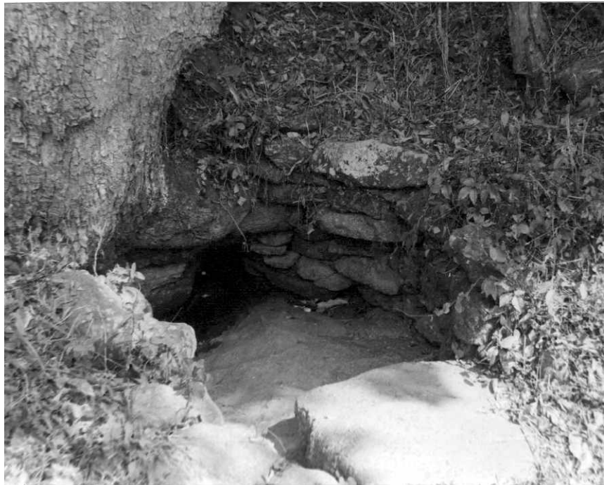
Poço de pedra. A comunidade se abastece com a água de vários poços deste tipo.
